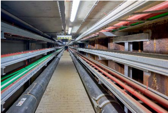
Afbeelding 4.7 | Integrale leidingtunnel (ILT) | Projectbureau Zuidas
